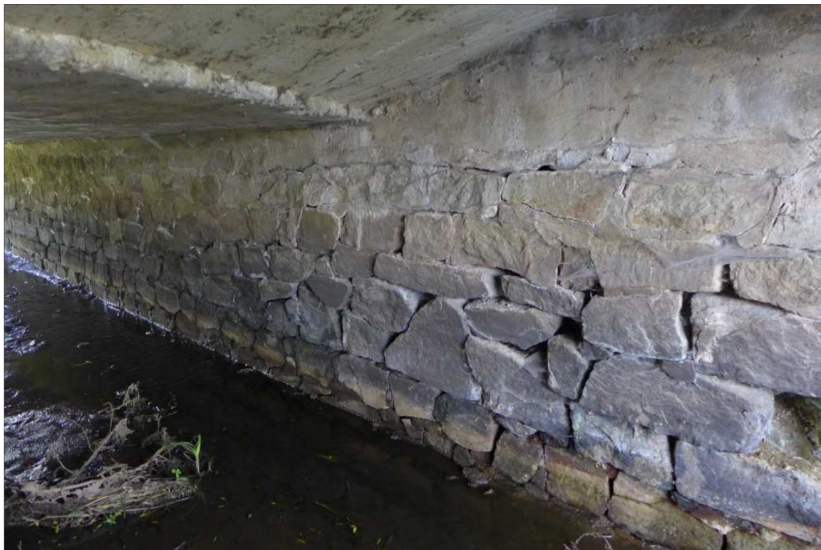
Fot. 13 – Przyczółek prawobrzeżny - widoczne rozluźnienie i przemieszczenie elementów kamiennych, ubytki spoin i elementów kamiennych.
