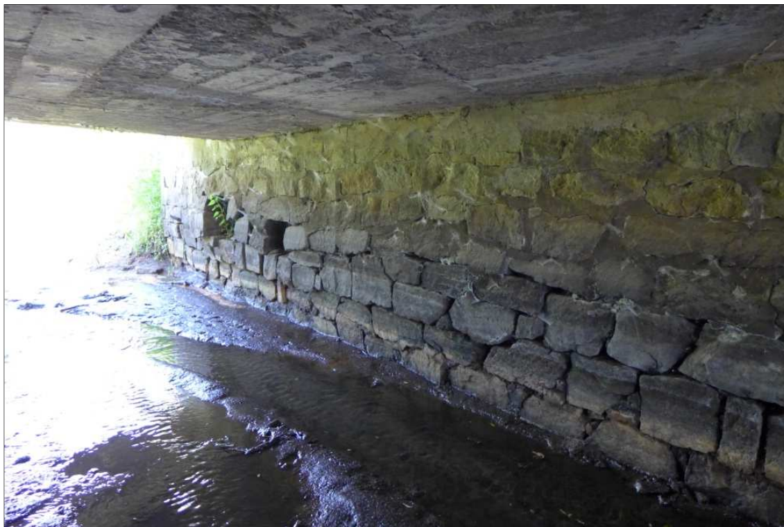
Fot. 17 – Przyczółek lewobrzeżny - widoczne ubytki spoin, rozluźnienie i ubytki elementów kamiennych.
