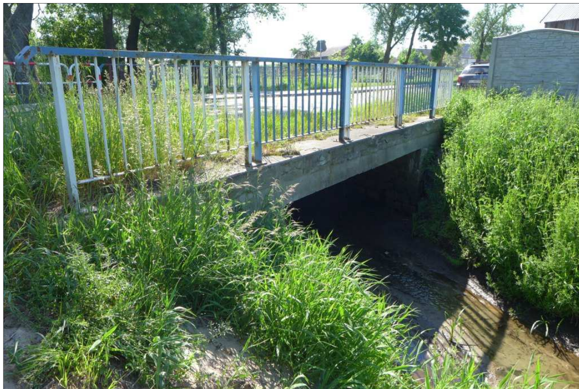
Fot. 3 – Widok od dolnej wody
