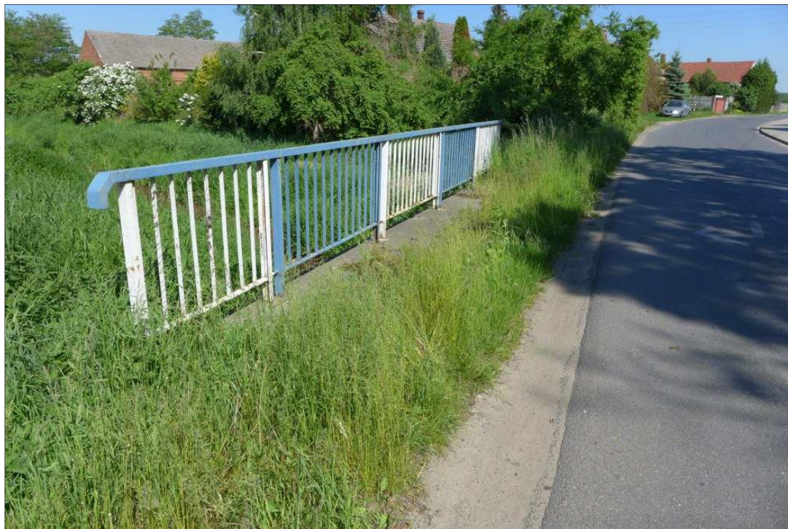
Fot. 7 – Pobocze od strony dolnej wody - widoczna bujna wegetacja roślin w strefie przykrawężnikowej.
