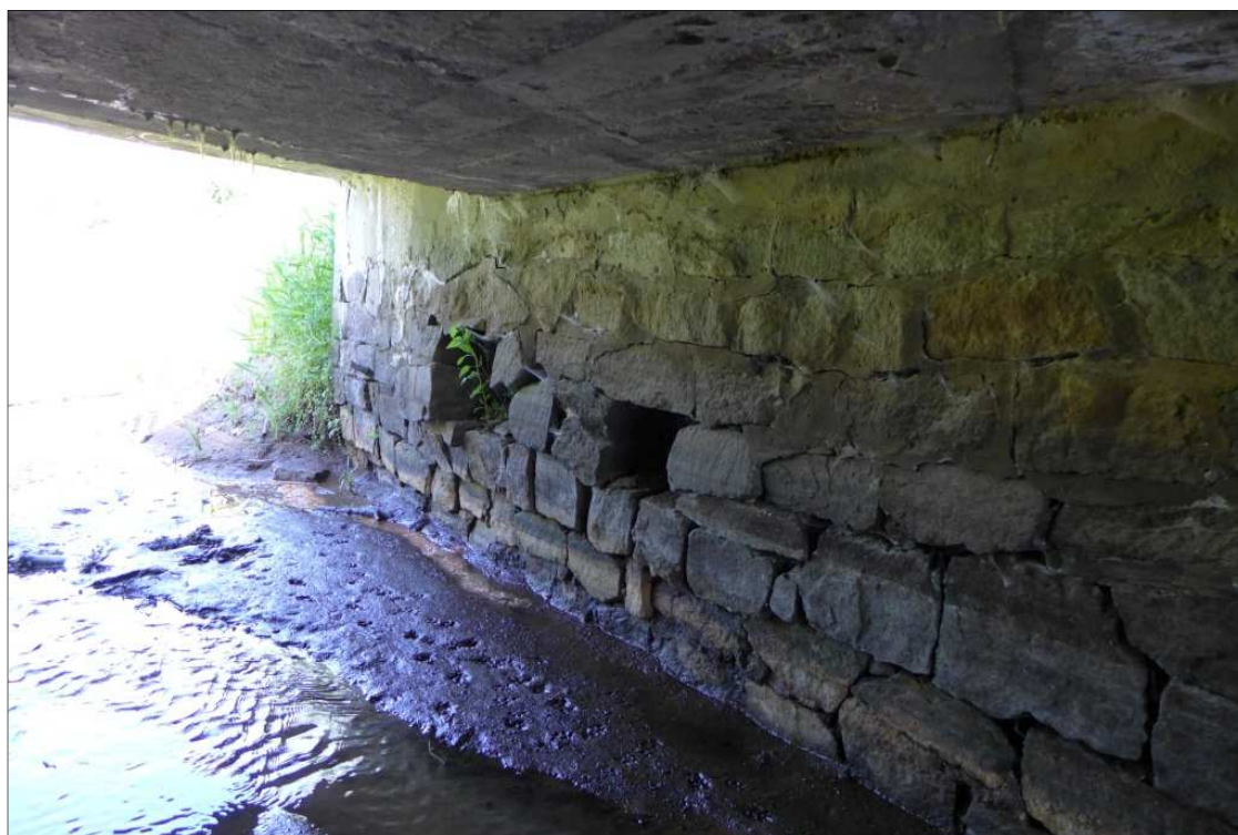
Fot. 18 – Przyczółek lewobrzeżny - widoczne ubytki spoin, rozluźnienie i ubytki elementów kamiennych.
