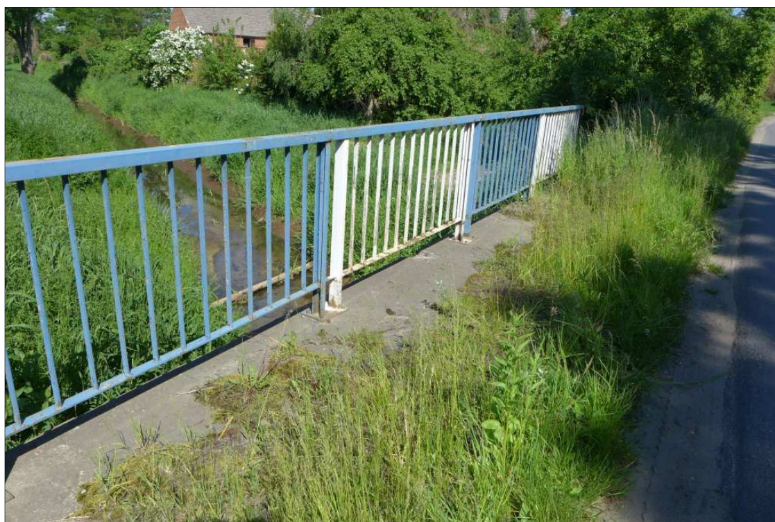
Fot. 8 – Pobocze od strony dolnej wody - widoczne zanieczyszczenia, wegetacja roślin, złuszczenie powłok malarskich elementów balustrady.
