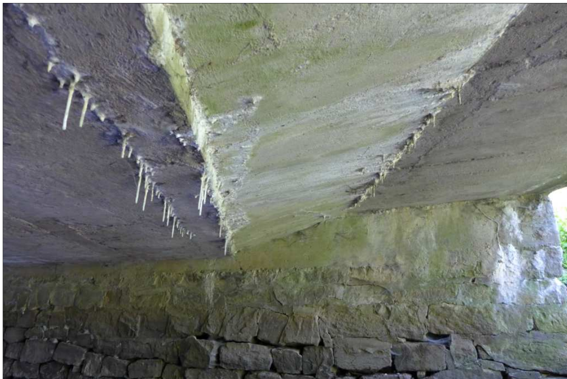
Fot. 11 – Konstrukcja nośna - widoczne osady i wykwity.
