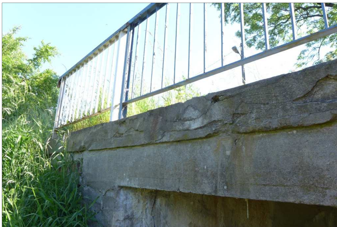
Fot. 10 – Gzysm od strony dolnej wody - widoczne spękania, ubytki betonu.
