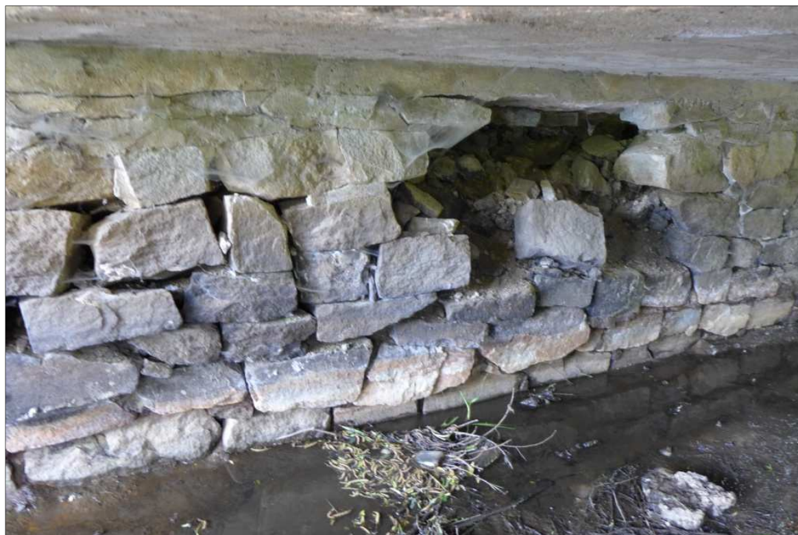
Fot. 14 – Przyczółek prawobrzeżny - widoczna znaczna wyrwa w konstrukcji kamiennej przyczółka, ponadto przemieszczenie pozostałych elementów kamiennych, ubytki spoin.
