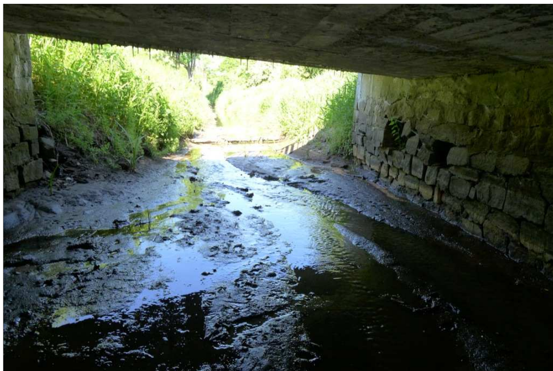
Fot. 4 – Przestrzeń podmostowa
