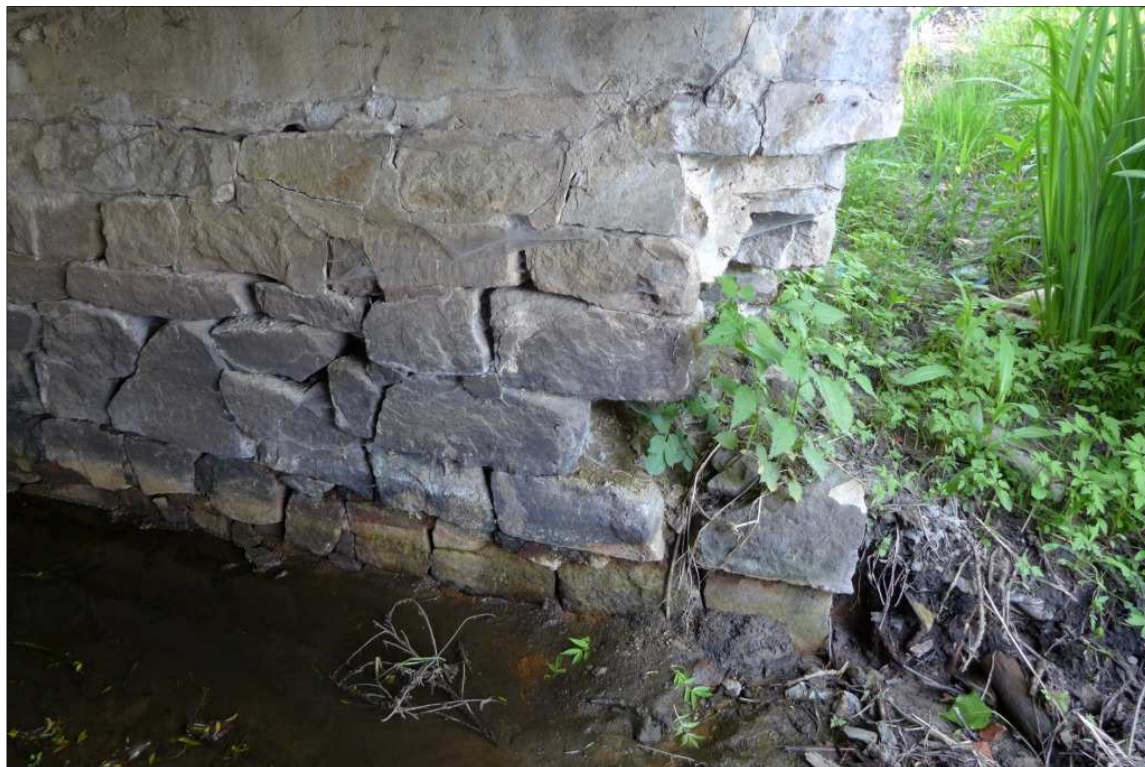
Fot. 15 – Przyczółek prawobrzeżny - skrzydło od strony górnej wody - widoczne znaczne ubytki elementów kamiennych, wegetacja roślin.
