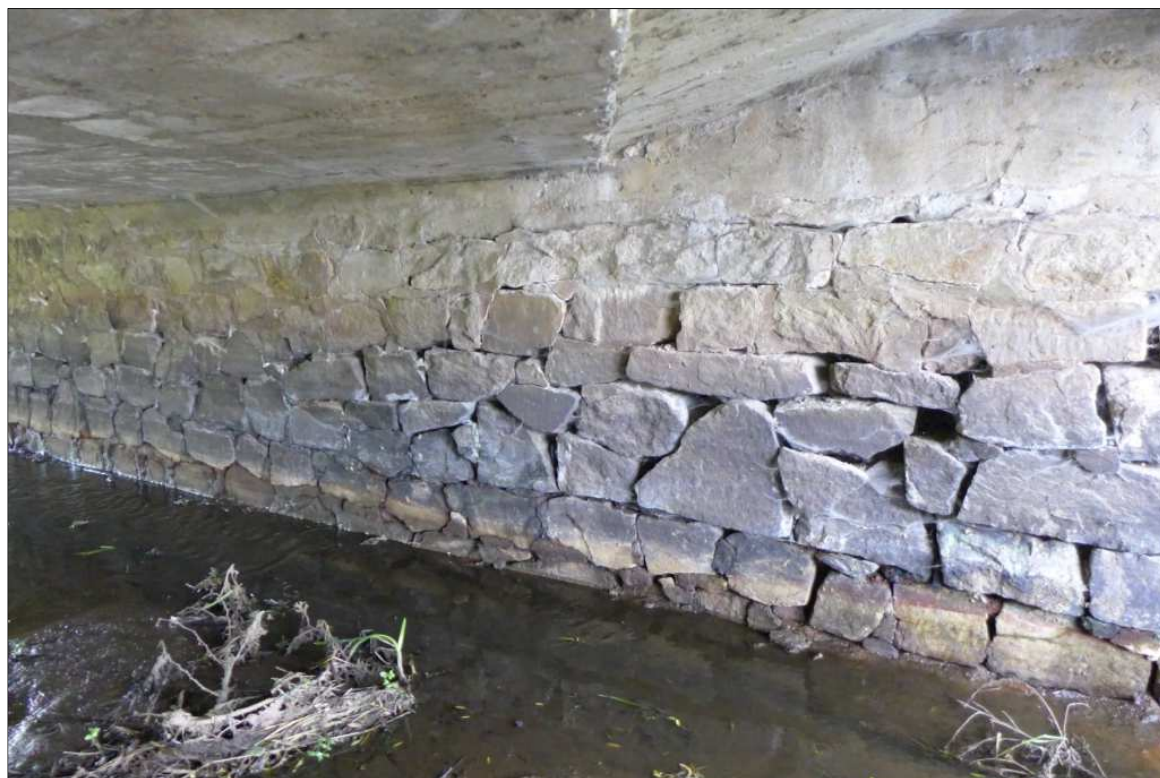
Fot. 16 – Przyczółek lewobrzeżny - widoczne ubytki spoin, rozluźnienie i przemieszczenie elementów kamiennych.
