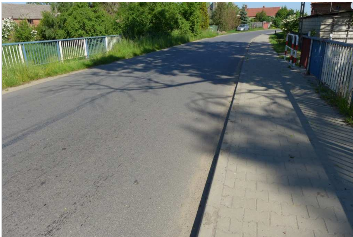
Fot. 5 – Nawierzchnia jezdni - zanieczyszczenia w strefie przykrawężnikowej.
