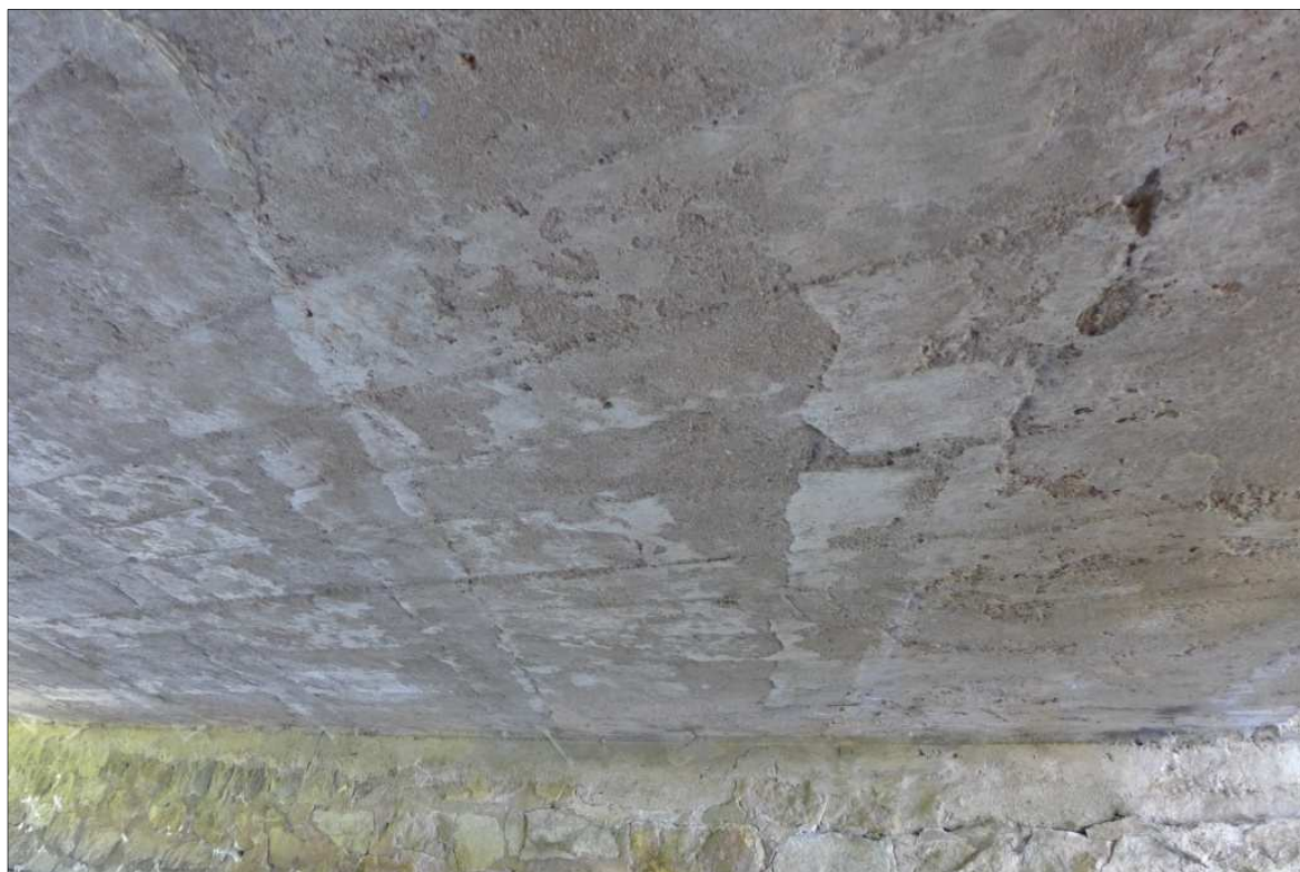
Fot. 12 – Konstrukcja nośna - widoczne spękania, wykruszenia betonu.
