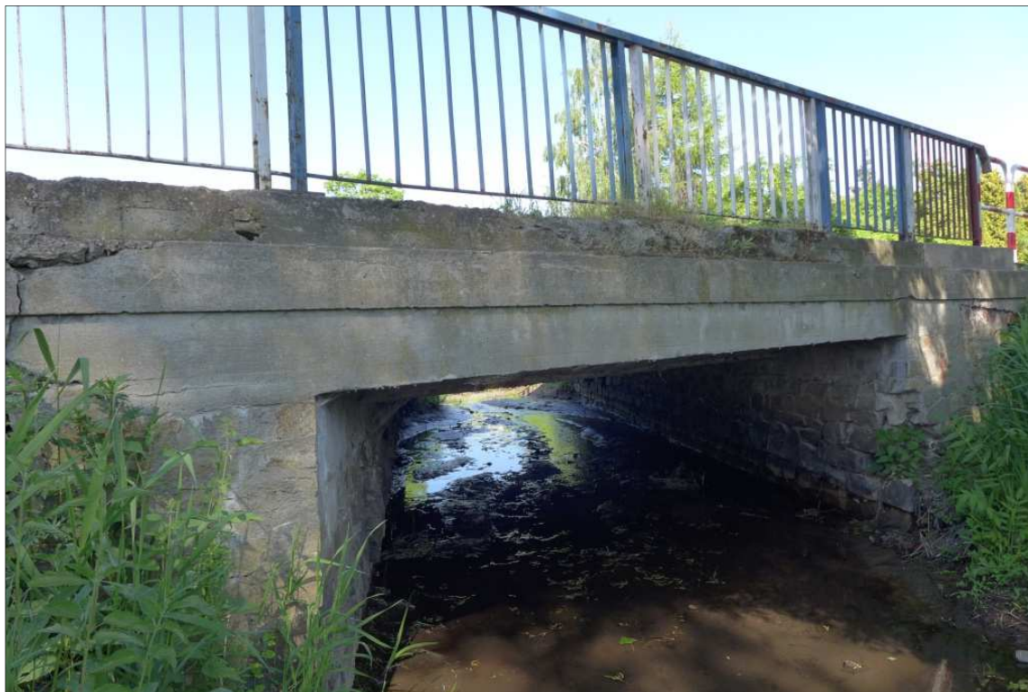
Fot. 9 – Gzysm od strony górnej wody - widoczne spękania, wykruszenia betonu, wegetacja roślin.
