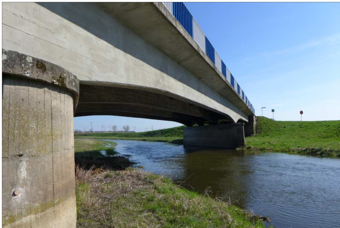
Fot. 4 - Przestrzeń pomostowa
