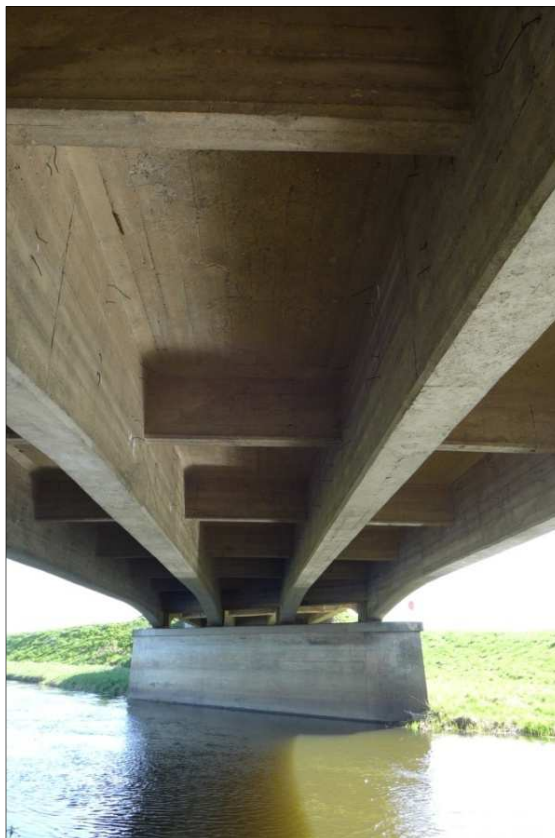
Fot. 19 – Konstrukcja nośna (przęsło nurtowe) - brak znaczących uszkodzeń, lokalne złuszczenia betonu.
