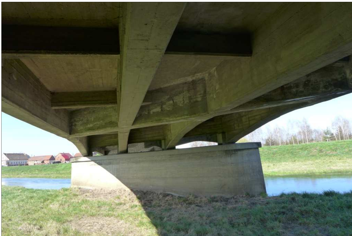
Fot. 21 – Konstrukcja nośna (pręślo od strony Żmigrodu) - brak znaczących uszkodzeń, poza strefą przegubu.
