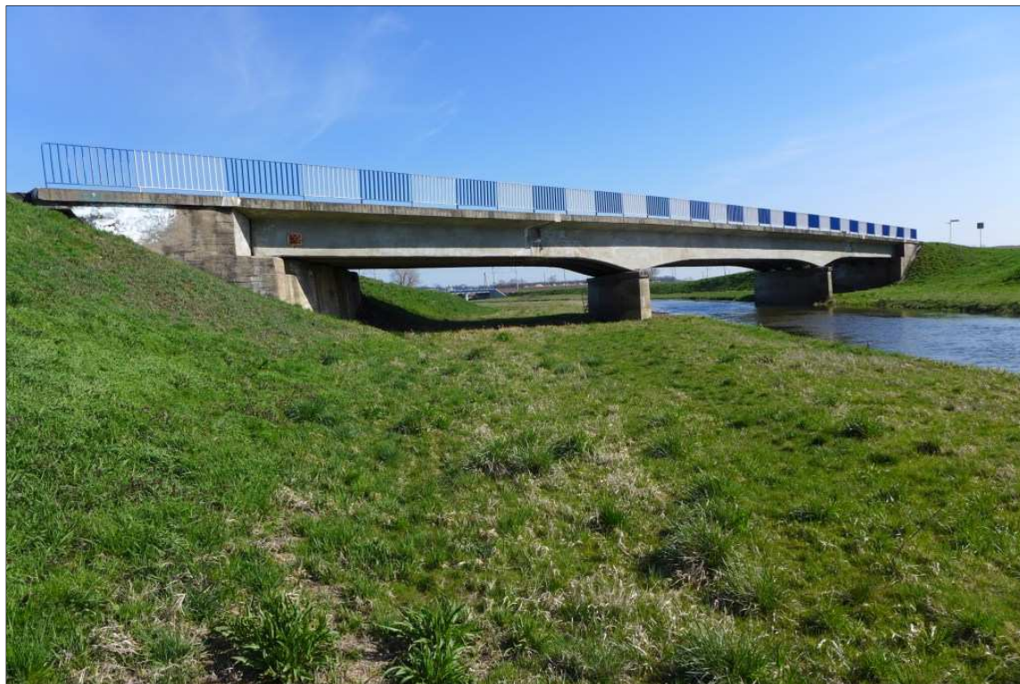
Fot. 3 – Widok od dolnej wody
